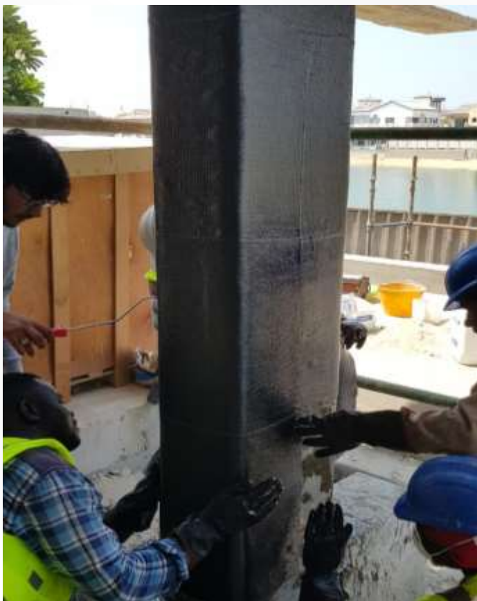
Wzmocnienie nośności słupa
