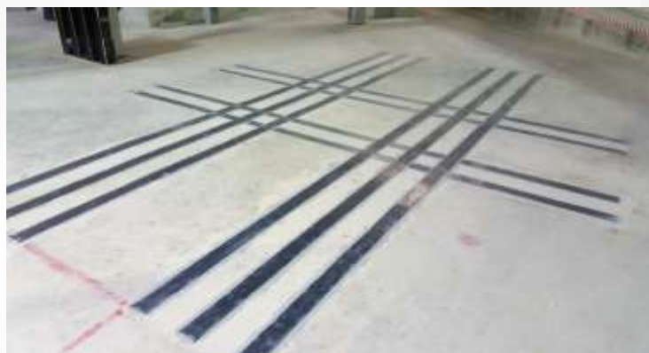
Wzmocnienie nośności płyty
